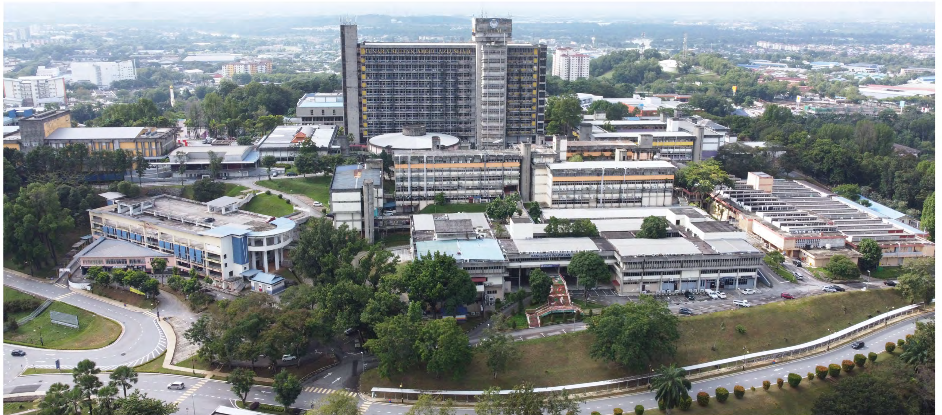
Bangunan 14 tingkat ini tersergam megah sejak 1972.
